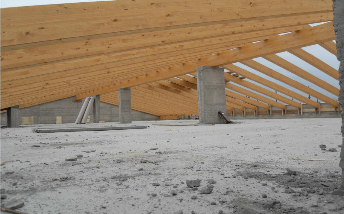
I sottotetti a vista saranno isolati, impermeabilizzati e ventilati, dopo di che verrà eseguito manto di protezione costituito da tegole del tipo "portoghese" o similare.
