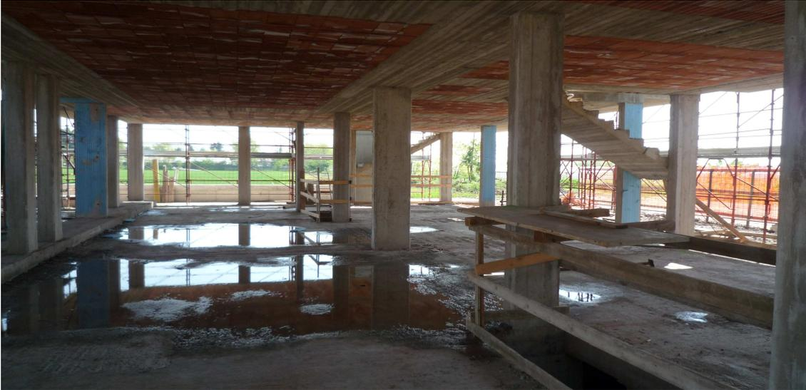
I solai per il piano interrato, invece, saranno realizzati con lastre prefabbricate in calcestruzzo e blocchi di alleggerimento in polistirolo, getto in opera di cappa e nervature; la parte inferiore del solaio sarà Costituita da lastre "a vista".
